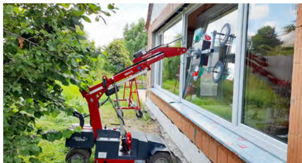
Für den Außeneinsatz geeignet, um Fenster von außen nach innen zu versetzen
