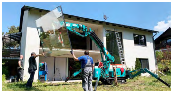
Der MK 1033 basiert auf dem MC 285 (siehe Seite 100) und kann über Vorsprünge und Balkone verheben
