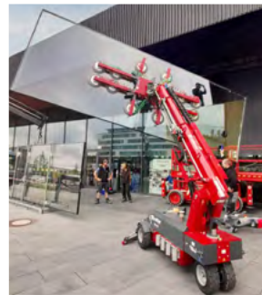
Durch die besondere Bauweise können Bauelemente gedreht werden
