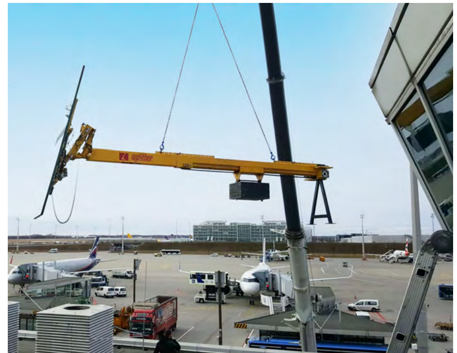
Verglasung unter Dachvorsprüngen und Gebäude-Neigungen
