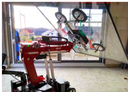
Manuelles Kippen, Schwenken und Drehen
