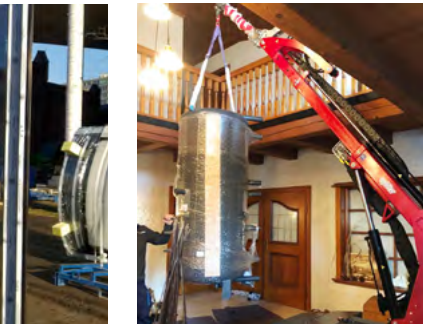
Kranspitze für Lasten bis 250 kg
